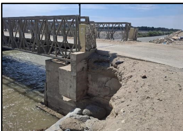
FIGURA N°02: EL SECTOR EL CARMEN SE APRECIO DESLIZAMIENTO DE DIQUE POR SOCAVACION
